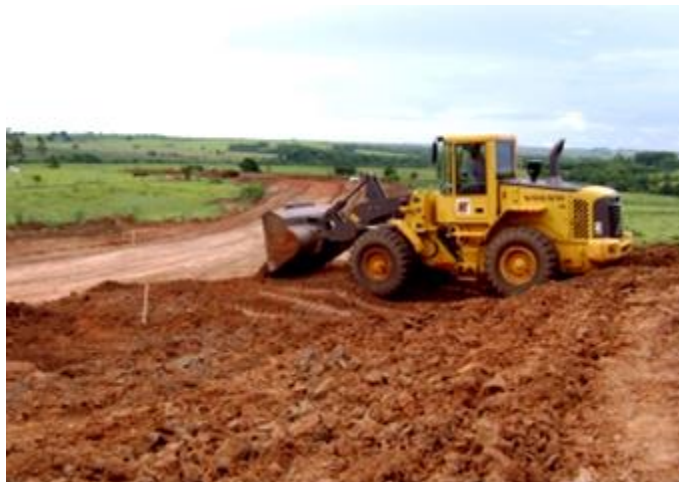
Figura 5: Obra de terraplenagem
