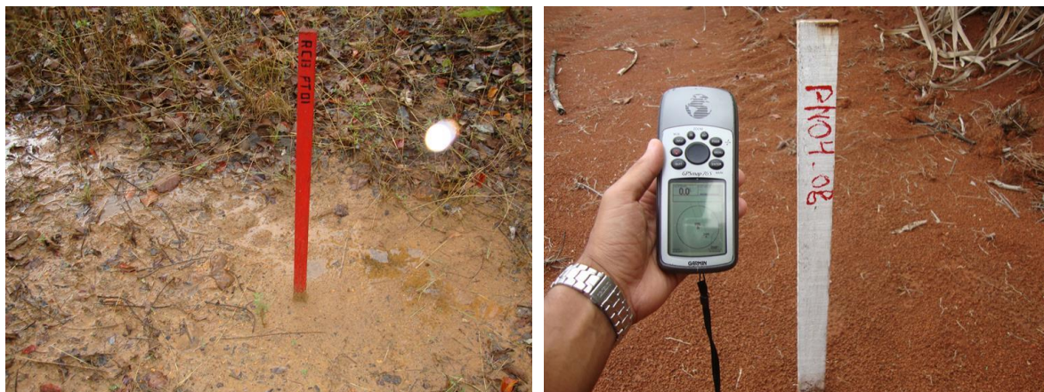
Figura 4: Exemplos de estaqueamentos provenientes de locação topográfica de projetos hidroambientais
