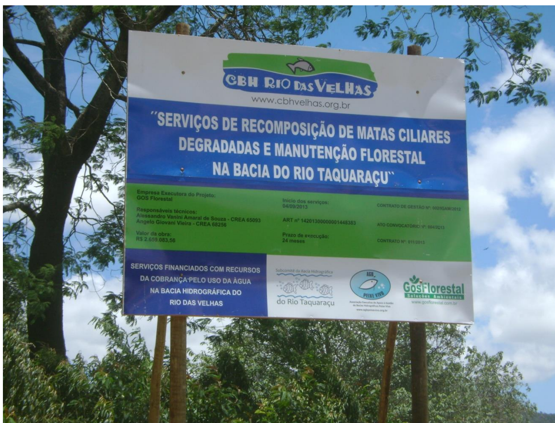
Figura 20: Placa de responsabilidade técnica instalada em projeto hidroambiental na bacia hidrográfica do rio Taquaraçu.
