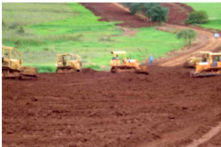
Figura 6: Raspagem do solo
