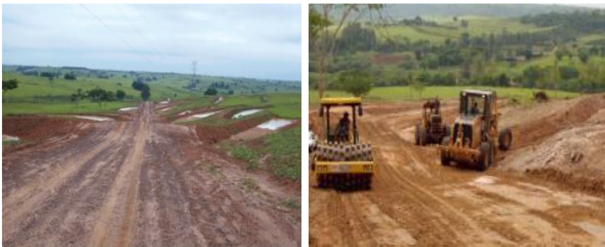
Figura 7: Construção dos bigodes ou terraços
