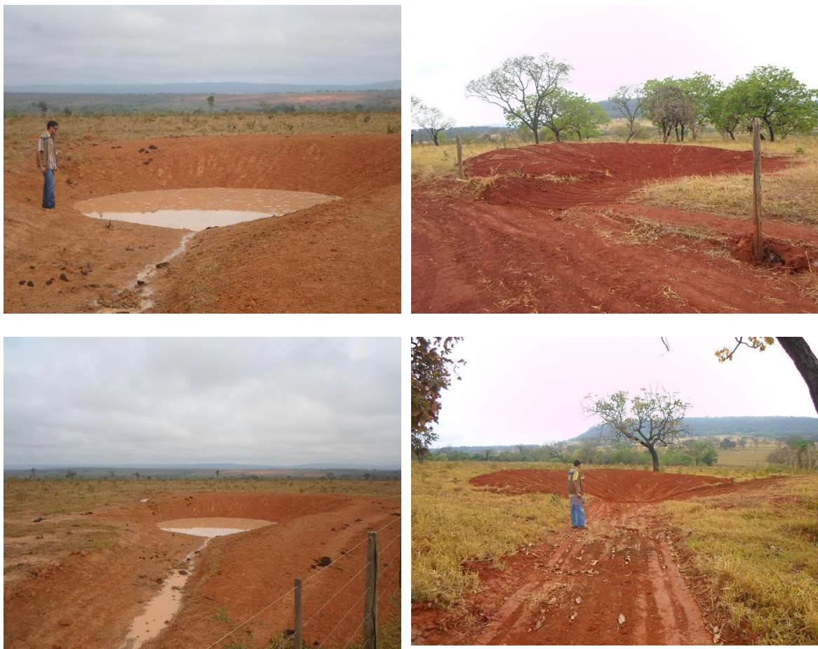
Figura 10: Bacias de captação de águas pluviais para coleta de enxurrada gerada em estrada rural
