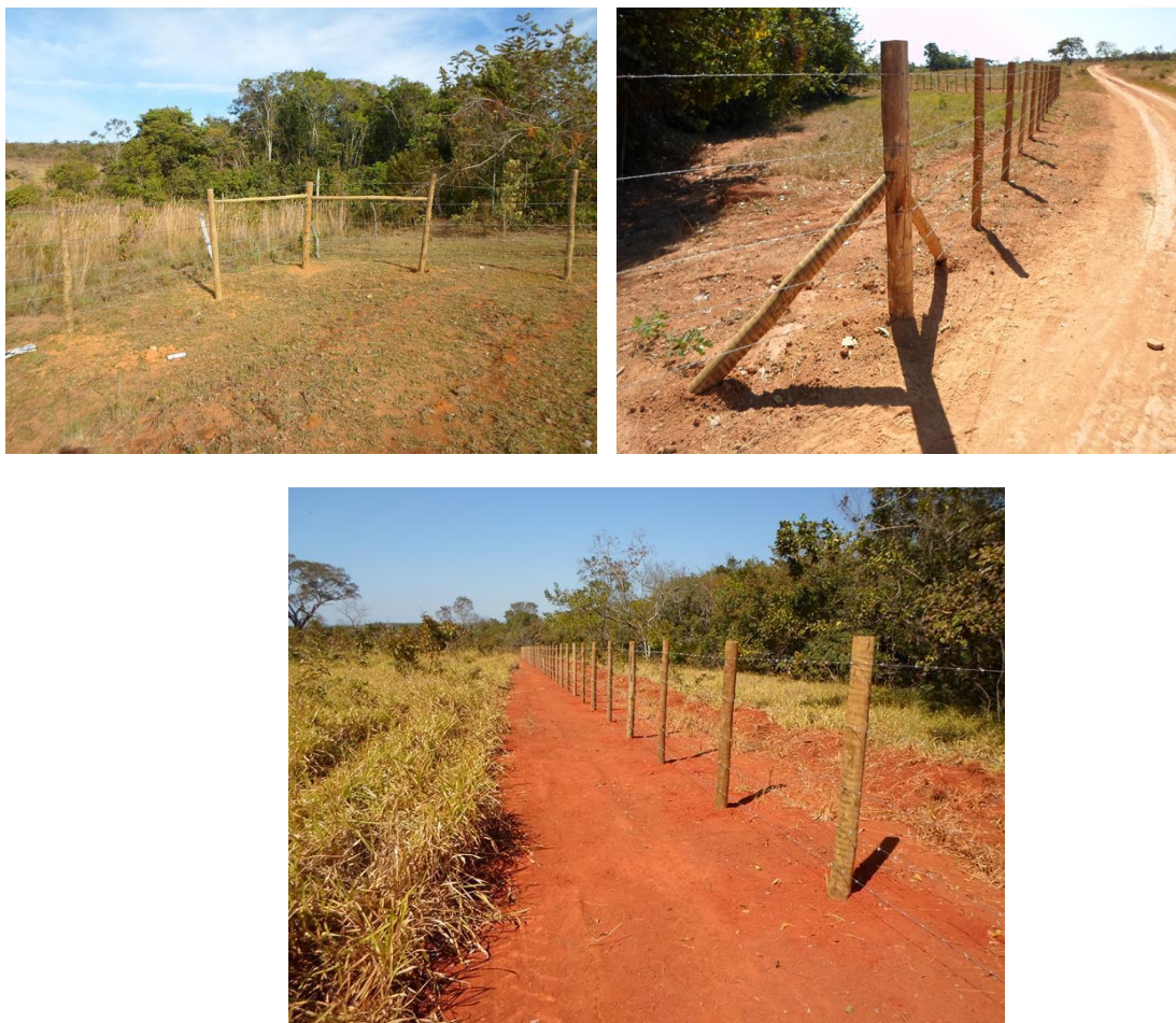
Figura 19: Cercas construídas em projetos hidroambientais na Bacia do Rio São Francisco
